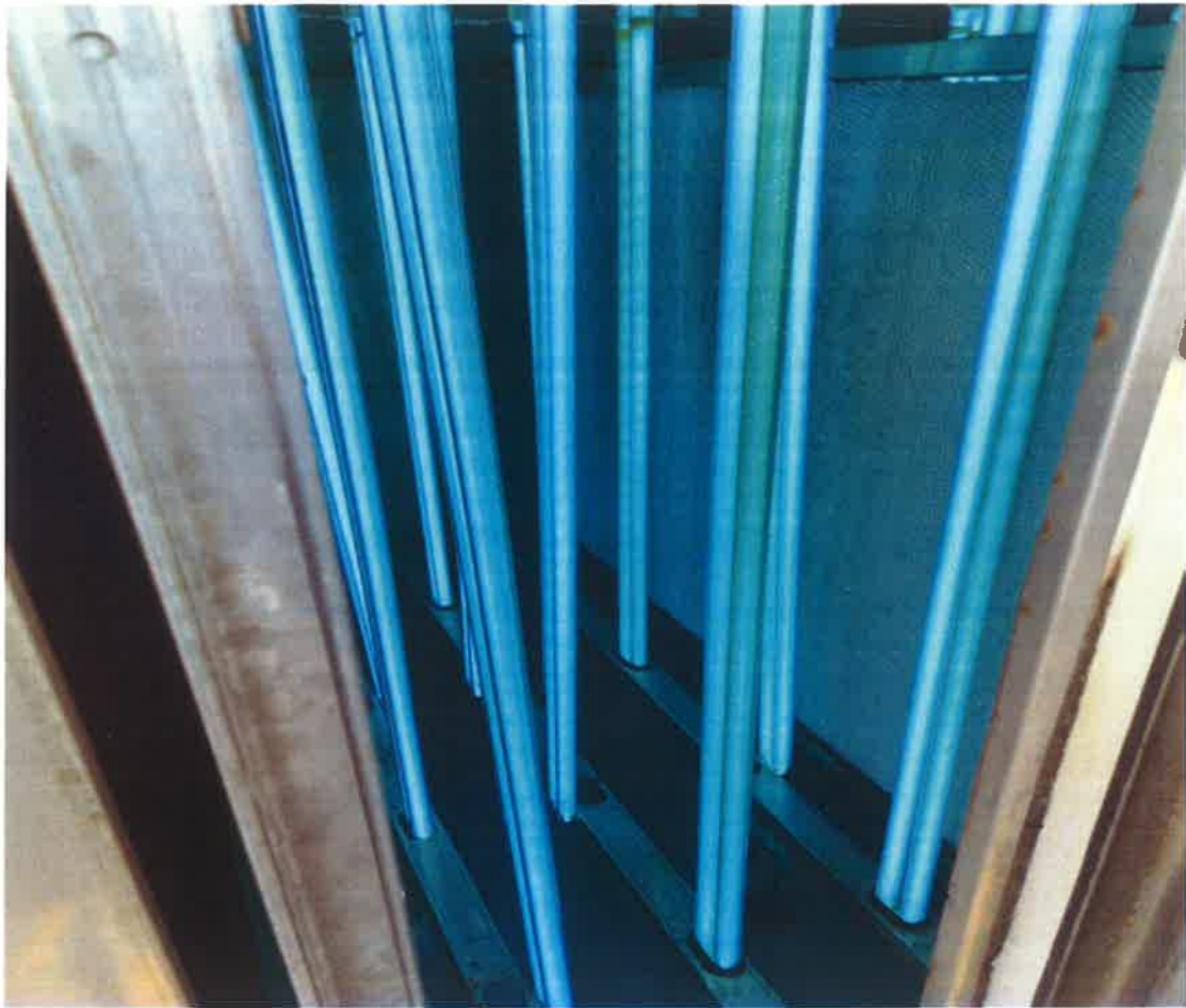
图 43 VOC 净化装置（UV 光氧催化）
