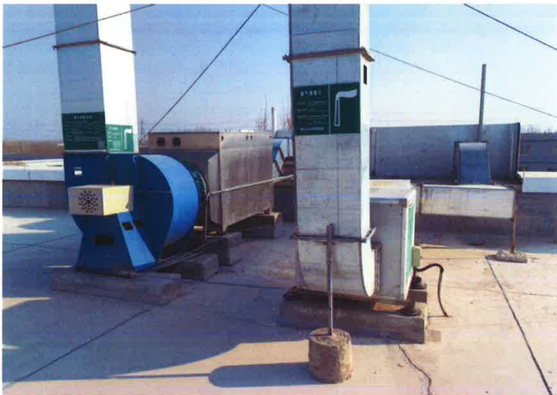
图 44 VOC 净化装置（活性炭吸附+UV 光氧催化）
